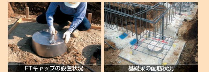
FTキャップの設置状況
