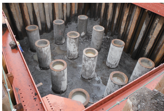
施工後の杭頭部掘削状況
