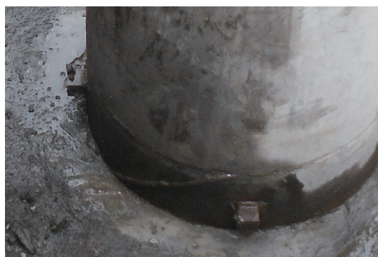
施工後の杭頭部掘削状況
