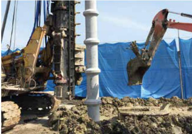
Hyper-MEGA工法は、最下杭に節杭を配置すること以外には、上杭・中杭にあらゆる既製杭を接続することができます。支持地盤も砂質、礫質、粘土質に対応しており、拡大比・拡大掘削長を変えることで、自由度の高い、バリエーション豊かな設計を可能にしたプレボーリング系高支持力工法です。
