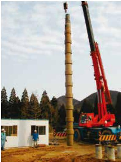
MRX工法は、杭径+100mmの掘削ビットと拡大翼を備える攪拌拡大ロッド(改良拡大部径は改良軸部径+150mm以上)及び拡大翼の開閉が確認できる確認装置等を用いて、地盤に応じた所定速度で、杭周改良液を所定量注入しながら掘削攪拌してソイルセメントと改良柱体を築造します。所定改良深度に達したら、先端固定液に切り替え、攪拌拡大ロッドの拡大翼を開かせ、上下反復することで改良拡大部を築造する。節形状築造が完了したら、拡大翼を閉じ、攪拌拡大ロッドを引き上げます。そして、先端開放型の既製コンクリート杭を自沈または回転によって所定位置に設定する工法です。
